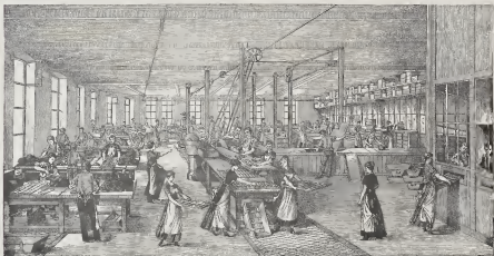
Installation de M.M. Stoilwerck frères de Cologne.
